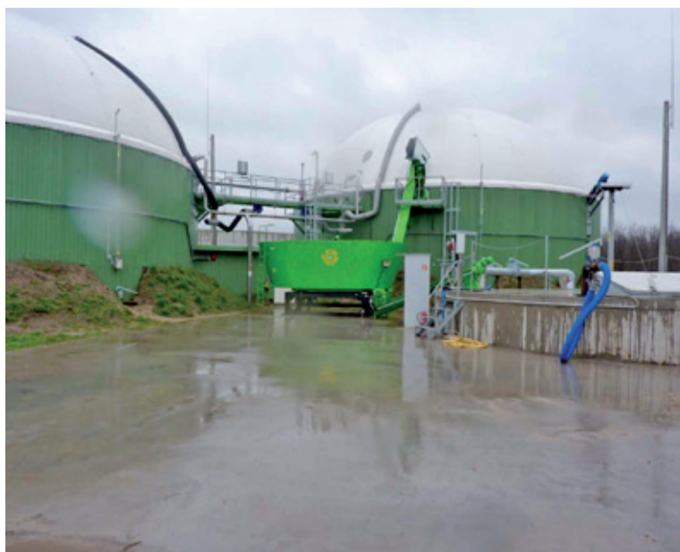
Bioplynová stanica: dva fermentori, uprostred dávkovací voz z rezacím zariadením, vpravo homogenizačná nádrž.
